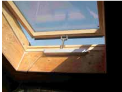
Figuur 5-2: Klepraam met motortje voor automatisch ventileren met domotica in de zomer (overgenomen van [5, pag. 12])
