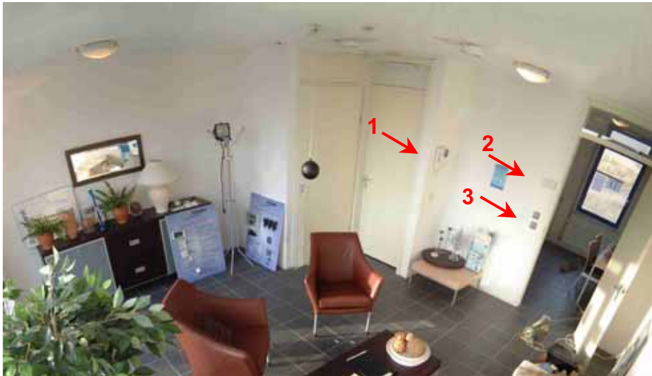
Figuur 5-1: Foto van het interieur van de onbewoonde domoticawoning op het ECN-terrein. Enkele uitlopers van het domoticasysteem zijn zichtbaar: een deurintercom (1), een intercom om via de alarmcentrale te communiceren met de meldkamer (2) en handschakelaars (3) die te programmeren waren voor diverse opties. De foto is gemaakt “vanuit het gezichtspunt van de aanwezigheidsdetector” [5, pag. 16], een ander onderdeel van het domoticasysteem. Meetsensoren zijn zo veel mogelijk weggewerkt, al is nog wel een zwarte bol te zien, hangend in het midden van de woonkamer, die bedoeld is om de temperatuur te meten. Foto (inclusief aangebrachte pijlen) overgenomen van [5, pag. 16].
